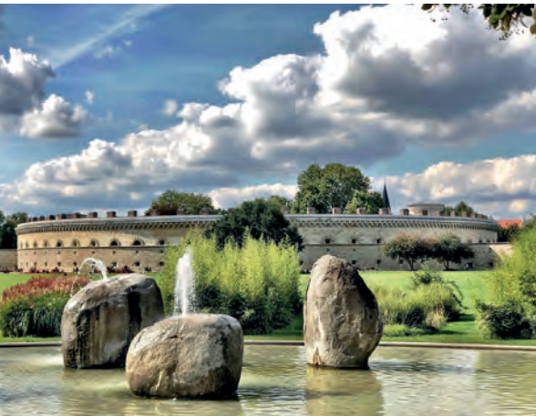
Festungsanlagen im Klenzepark
