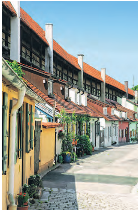
Stadtmauer mit den angebauten Kasarmen
