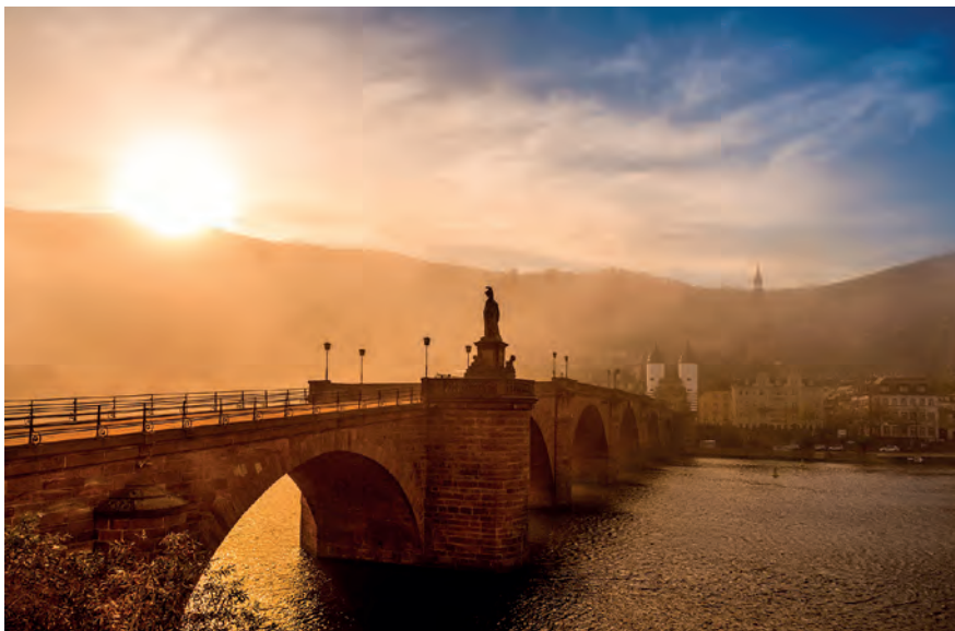
Alte Brücke, Foto © Heidelberg Marketing
